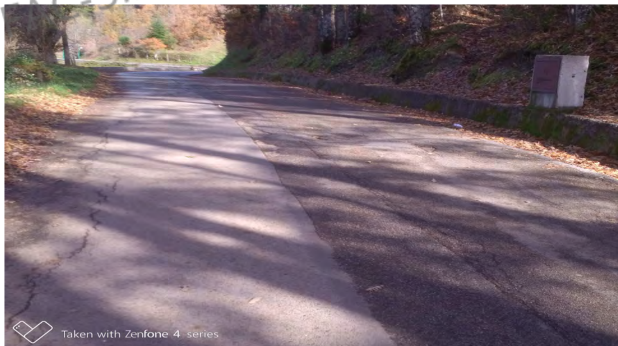
Intervento km 8+300 pavimentazione stradale
