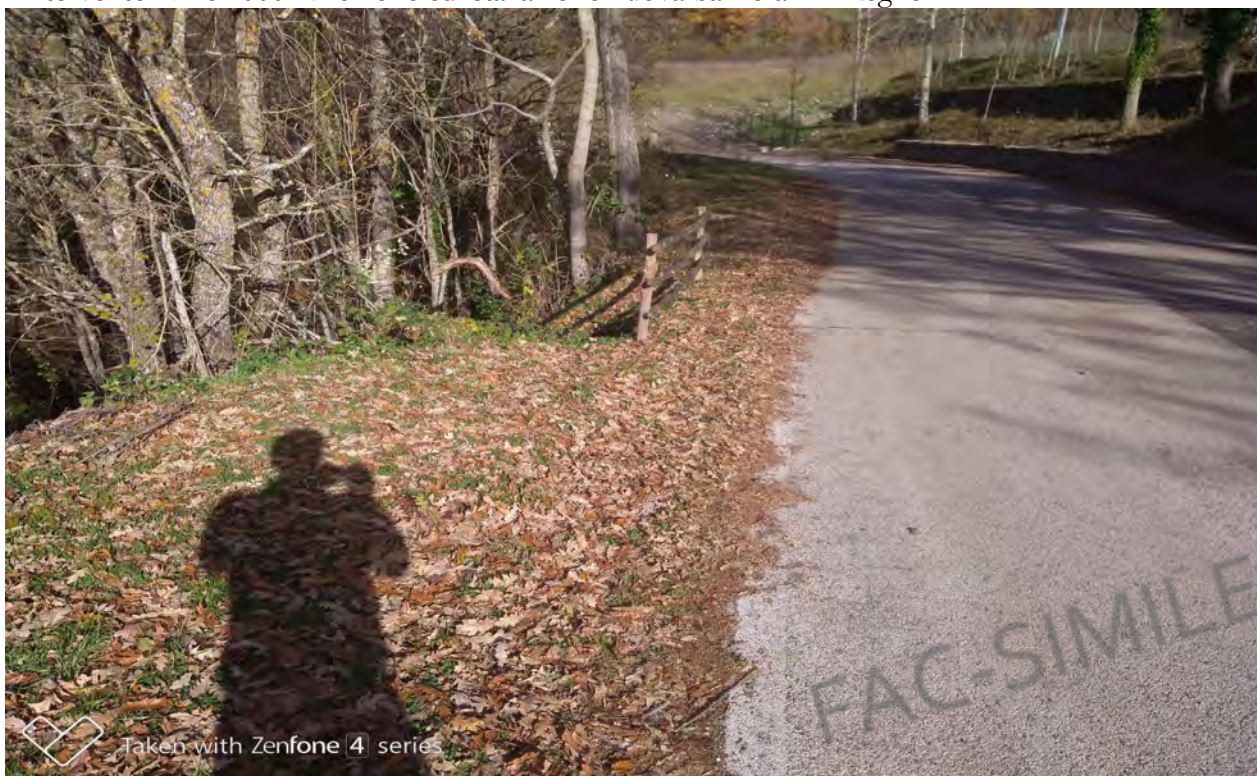
Intervento km 8+000 rimozione ed installazione nuova barriera "In Legno"
