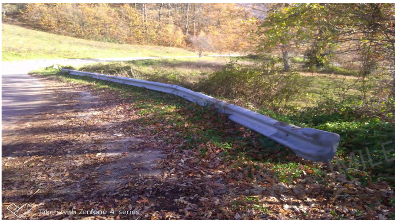
Intervento km 7+600 Istallazione barriera
