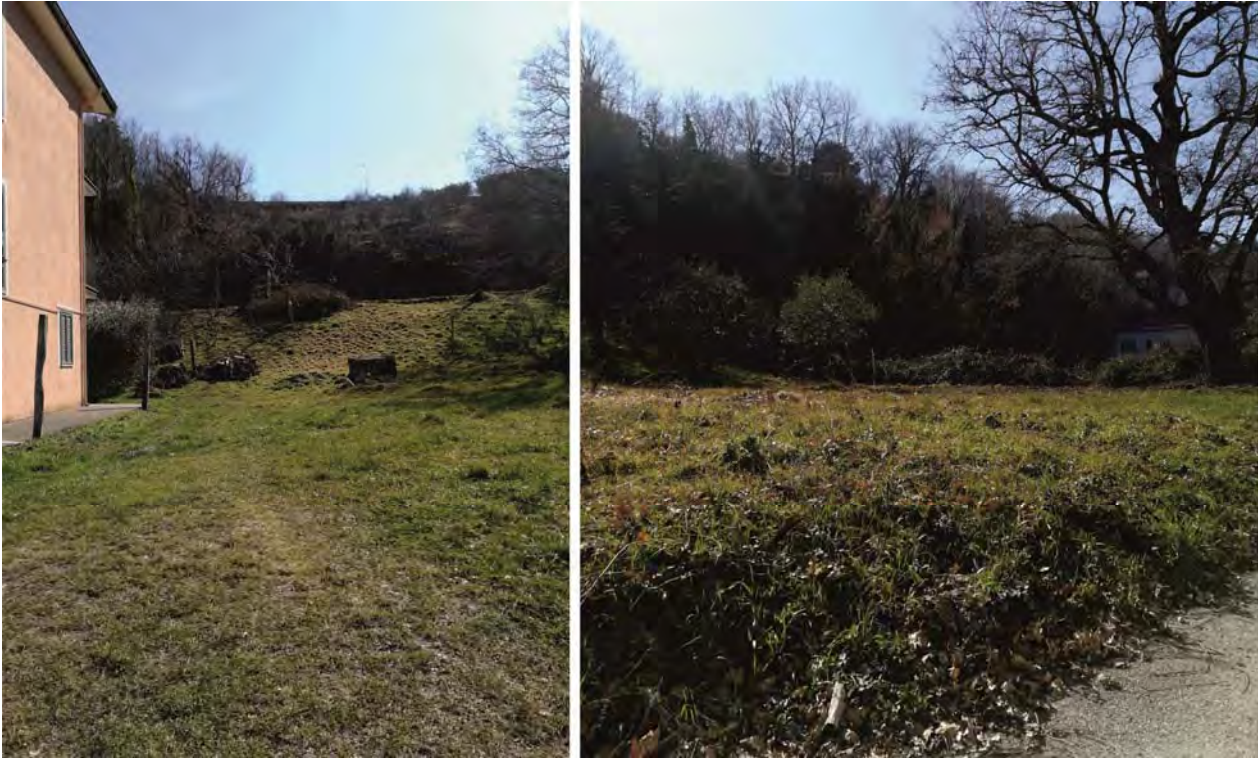
Fig. 8 – A sinistra: veduta da nord della frana che interessa il settore occidentale della SP ex SS104. A destra: veduta da nord-est della scarpata in conglomerati. Si noti il ripiano orizzontale presente immediatamente a valle del tratto stradale di progetto.
