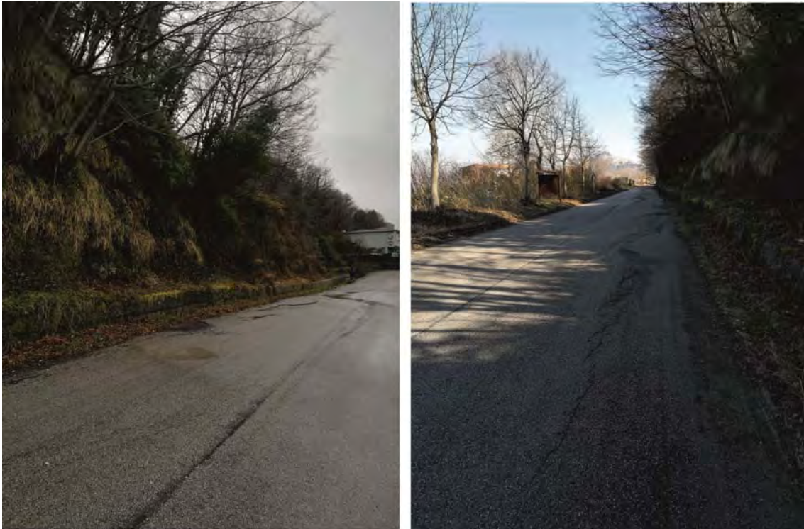
Fig. 9 – Danni alla sede stradale alla base della scarpata in conglomerati.
