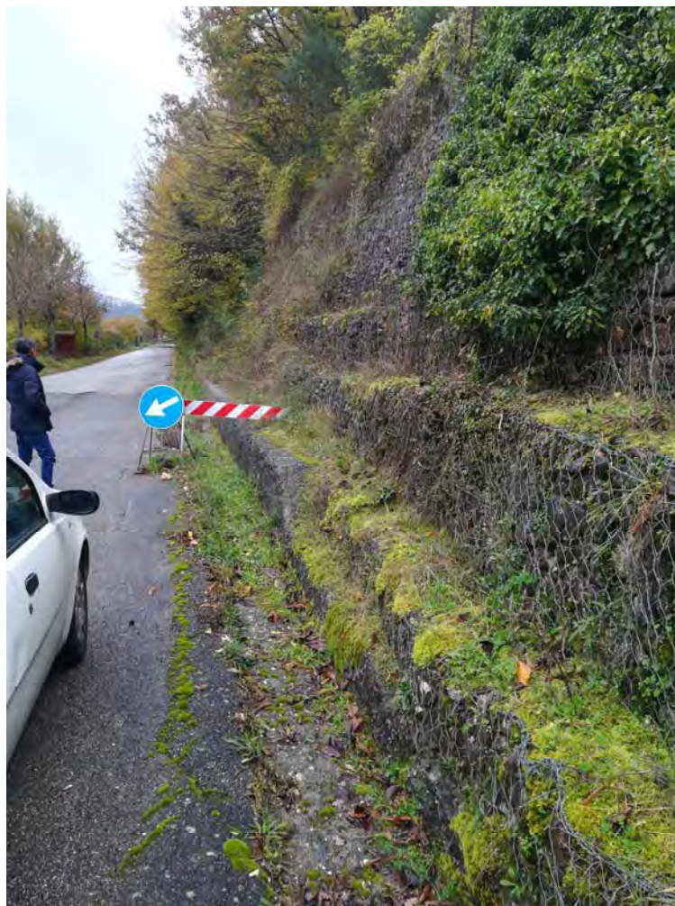
Figura 4 – Il sito di progetto con l'opera di sostegno e, sullo sfondo il grado di danneggiamento della strada.
